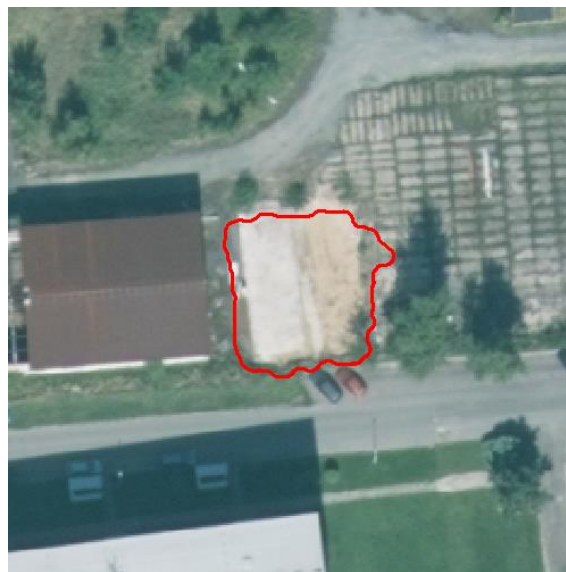
Obr. 20: Ortofoto ČR 2013 s vyznačenou zbouranou budovou
