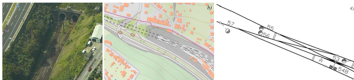
Obr. 1: Kolejiště před východními portály železničních tunelů Lamačský I a II: šikmý snímek portálů [5] (a), vizualizace ZBGIS ® [6] (b), výřez jednotné železniční mapy (c)
