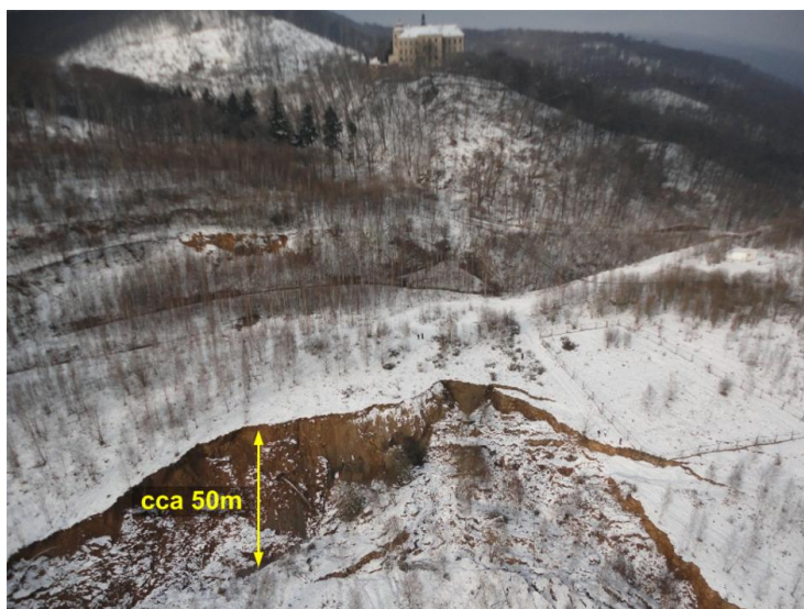
Obr.14: Sesuvy na piliři ochraňujícím zámek [0]
